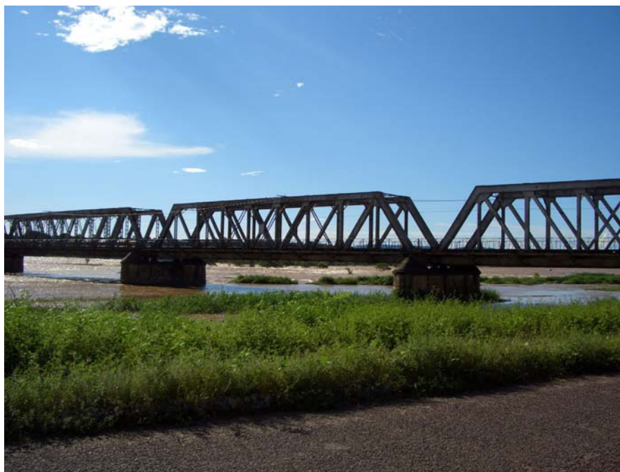
Figure 4.26 : Pont Marechal Hermes à Pirapora. Photo Rennó Mai/2007.
